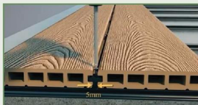
11. ติดตั้งไม้พื้นแผ่นถัดไป เลื่อนให้เข้าล็อกและยิงสกรูที่คลิปผ่านร่องจากด้านบน
