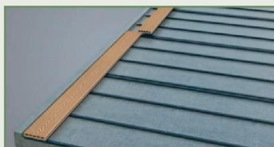
8. เรียงแผ่นไม้พื้น โดยให้ขอบเขา-ร่องด้านข้างแผ่นไม้พื้นเข้าล็อกกับคลิป
