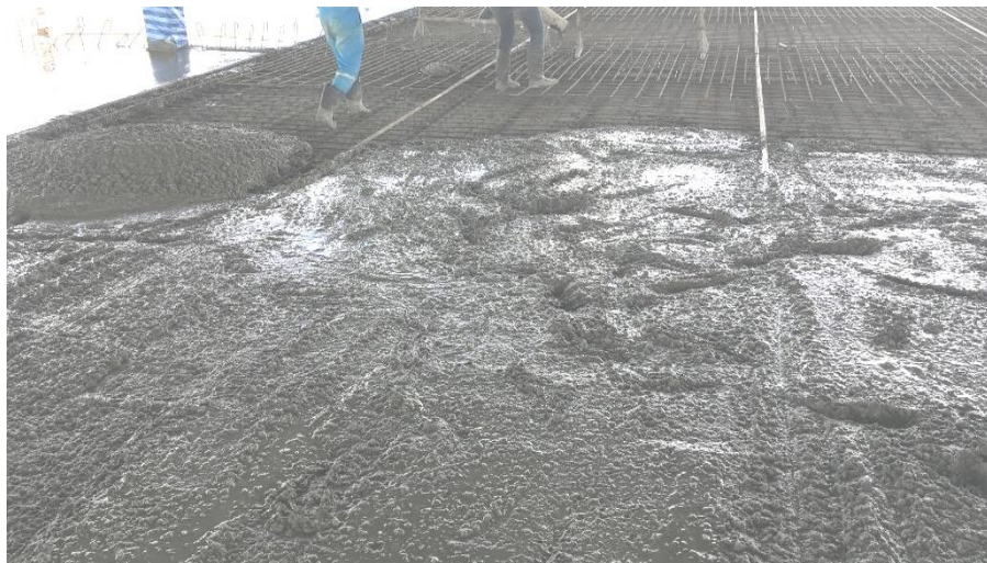
รูปที่ 20 แสดงการเทคอนกรีตทับหน้า และการปรับแต่งผิวหน้า
