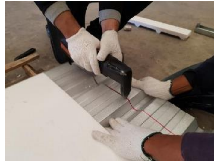
ตัดด้วยความความระมัดระวัง โดยตัดให้ตรงตามแนว เพื่อลดปัญหาการตัดซ้ำ
