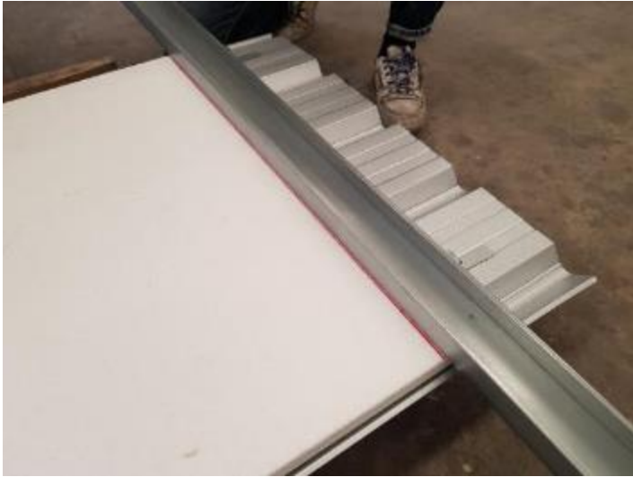
วัดระยะแผ่นตามที่ต้องการตัดและขีดเส้นแนวตัดบริเวณแผ่นฉนวน
