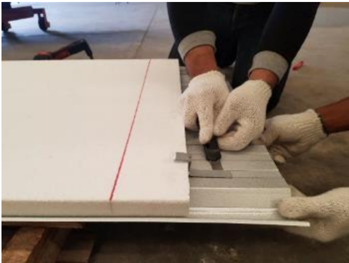
ใช้มีดคัตเตอร์เซาะเทปกาวของอุปกรณ์ยึดออกทั้ง 2 ข้าง
