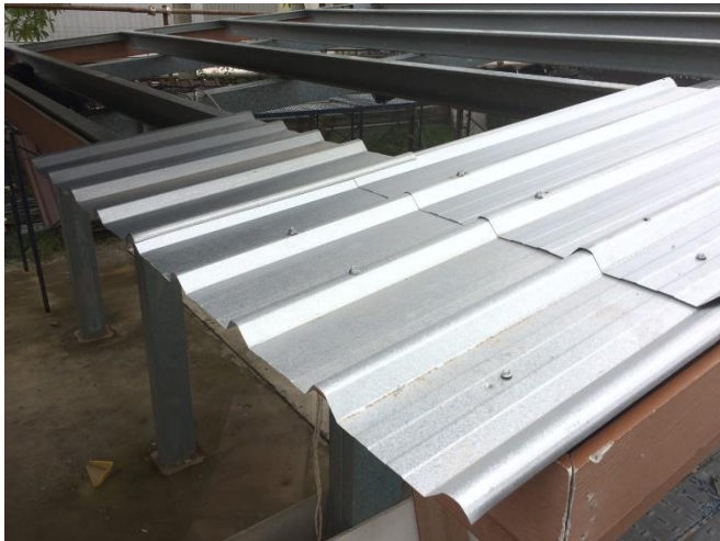
เริ่มติดตั้งแผ่นหลังคาแผ่นแรก จากด้านล่าง > ด้านบน และ จากด้านขวา > ด้านซ้าย
