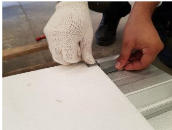
ติดตั้งอุปกรณ์ยึดที่เตรียมไว้แล้วโดยดึงเทปกาวออก และกดกับลงบนพื้นผิวหลังคาให้แน่น
