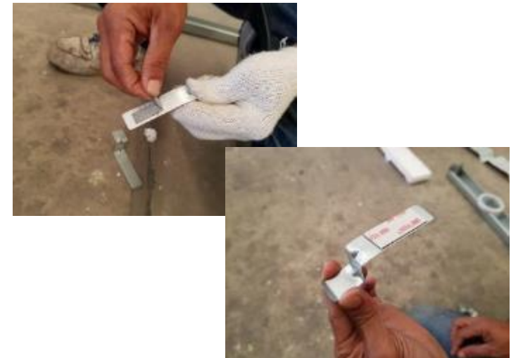
รื้อเทปกาวเดิมออกและติดตั้งเทปกาวใหม่ลงบนอุปกรณ์ยึด
