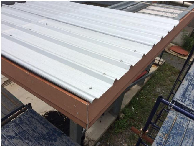
เริ่มติดตั้งแผ่นหลังคาแผ่นแรกจากด้านขวา > ด้านซ้าย
