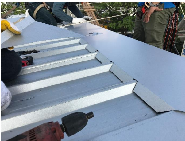
กรอบปิดหัวที่ถูกตัดลอนแล้วเสร็จ
