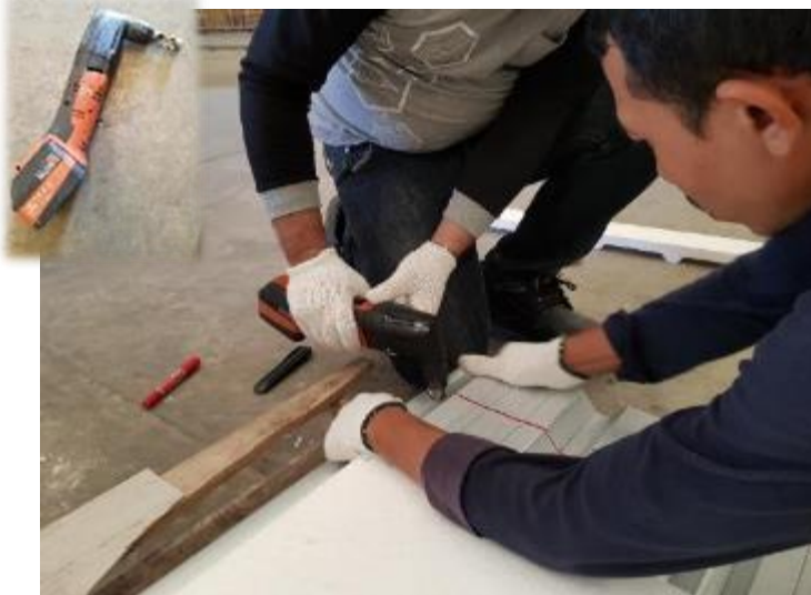
ตัดแผ่นหลังคาด้วยเครื่องตัดแผ่นหลังคาเหล็ก
