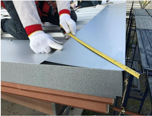
ติดตั้งกรอบปิดหัววัดระยะให้ทะแยงมุมกับระยะกรอบข้าง
