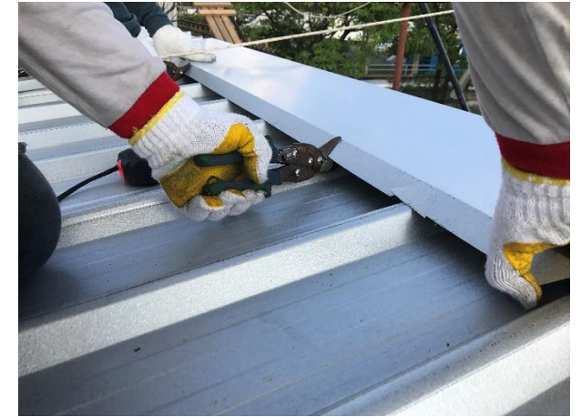
ตัดปีกกรอบปิดหัวทุกสันลอนด้วยกรรไกรตัดเหล็ก
