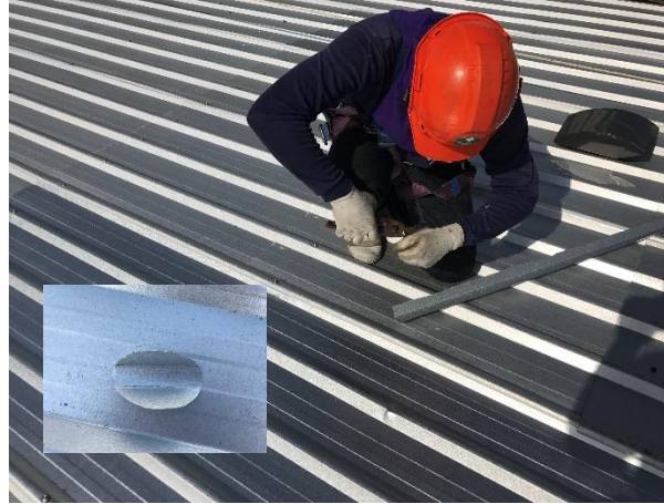
ตัดชิ้นงานเป็นลอนหลังคาเพื่อใช้ในการซ่อม
