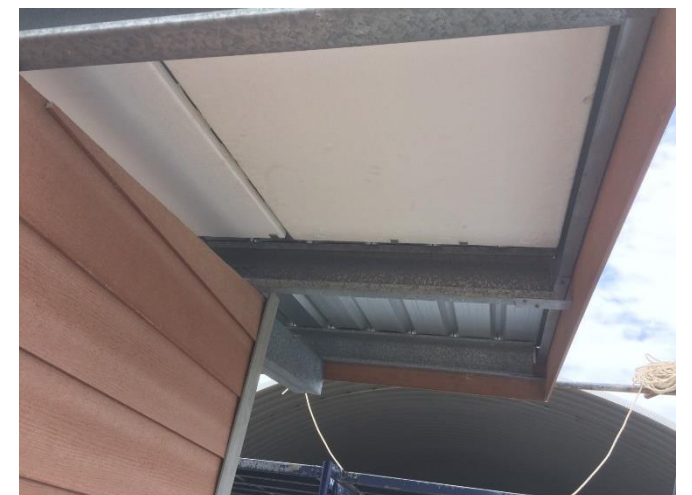
แผ่นเศษจะเป็นแผ่นที่ไม่มีลอนวนกันความร้อน เนื่องจากเป็นส่วนที่อยู่บริเวณชายคาของบ้าน
