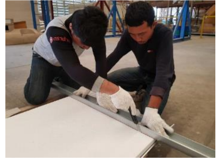
ใช้มีดคัตเตอร์ตัดแผ่นฉนวนตามแนวตัด
