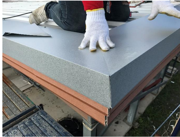
ตัดเฉียงและนำมาวางซ้อนทับบนกรอบข้าง
