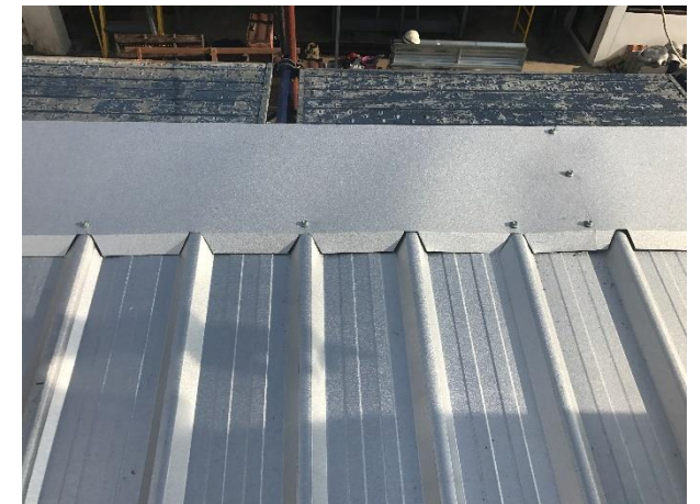
บริเวณสันลอนติดตั้งลอนเว้นลอน บริเวณรอยต่อกรอบติดตั้ง 3 จุด
