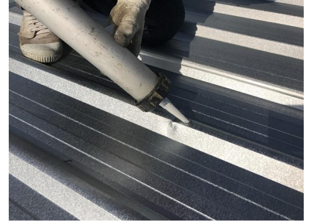
ใช้ทาว Cosmo Hybrid ทาบริเวณที่บุบในการยึดแผ่นเหล็ก
