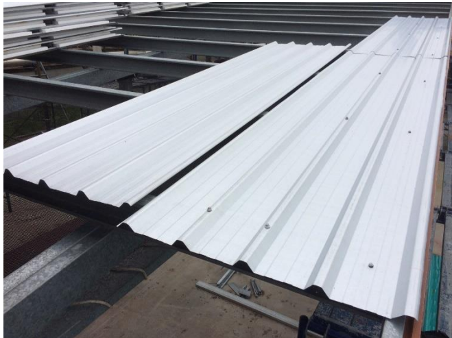
วางแผ่นหลังคาแผ่นถัดไป ให้สันลอนคว่ำ (ตัวเมีย) ทับสันลอนหงาย (ตัวผู้)
