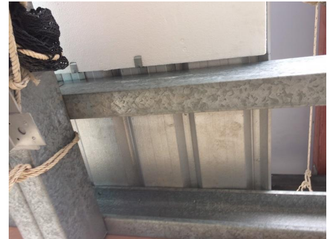
แผ่นเศษจะเป็นแผ่นที่ไม่มีฉนวนกันความร้อน เนื่องจากเป็นส่วนที่อยู่บริเวณชายคาของบ้าน
